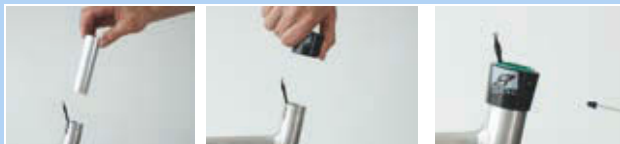
Rysunek 304: Montaż tulei ślizgowej i tulei zewnętrznej
